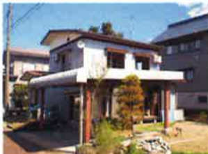
現在、解体工事中
