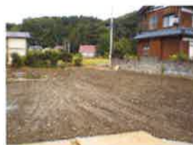
解体工事完了
